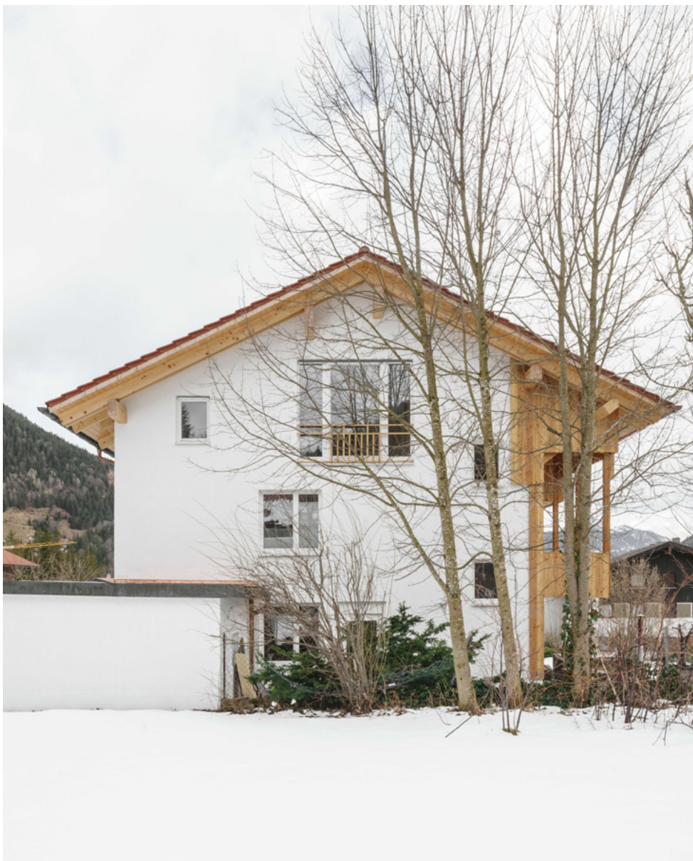
Im bayerischen Neuhaus passten Multerer Architekten zwei Doppelhaushälften für bis zu vier Parteien an. Dafür bauten sie den Dachraum aus und ergänzten eine schmale Gebäudeschicht. Mithilfe zweier doppelflügeliger Türen kann das Dachgeschoss problemlos zwischen einer durchgehenden Wohnung oder zwei unabhängigen variieren. Fotos: Sebastian Schels
