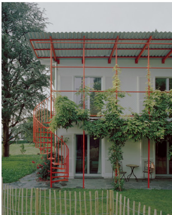
Mit wenigen Eingriffen vom Einfamilien- zum Dreifamilienhaus: Dominic Spalt Architektur gelang das im luxemburgischen Schaan mit einer Pergola, zwei Außentritten und einem Laubengang sowie Holzeinbauten und gezielten Durchbrüchen im Inneren. Fotos: Willem Pab
