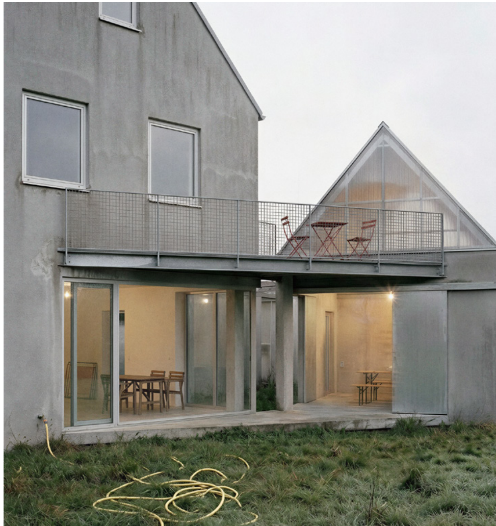
Gewohnt werden soll in dem Haus nach dem Umbau von Hölscher und Löffler trotzdem. Mit einer schlichten Ergänzung zwischen den Bestandsvolumen soll oben ein Balkon entstehen, während das Erdgeschoss für gemeinschaftliche Nutzungen wie etwa Seminare geöffnet werden kann. Bild: Nicolai Löffler
