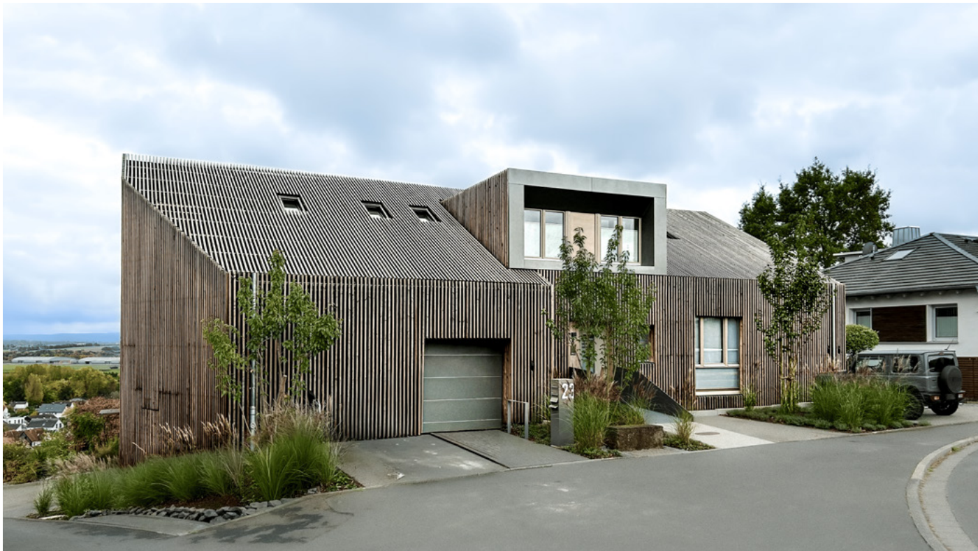
Vier Parteien in einem ehemaligen Einfamilienhaus: HHS Planer + Architekten machen in Fritzlär vor, wie es geht. Und dabei ist das Volumen kaum gewachsen. Foto: Gerhard Greiner
