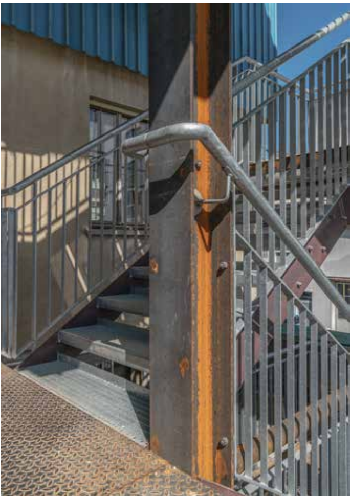
MITTE Die beiden außen liegenden Treppen bestehen hauptsächlich aus wiederverwendeten Bauteilen.
