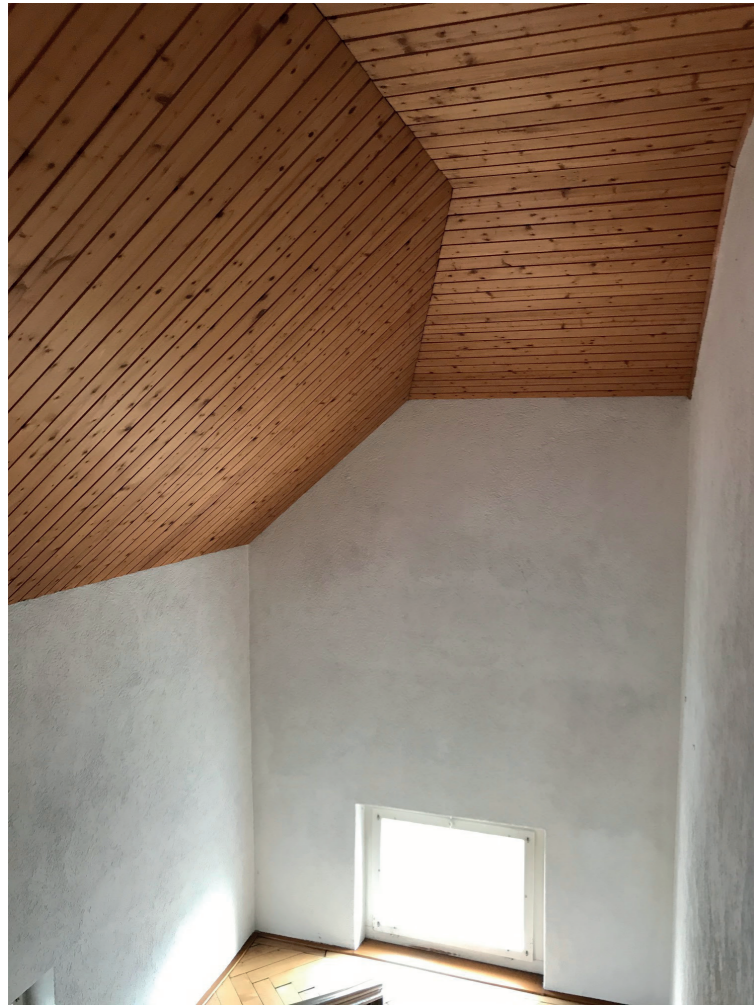
Im ehemaligen Treppenhaus wurden neu drei Badezimmer eingebaut.
