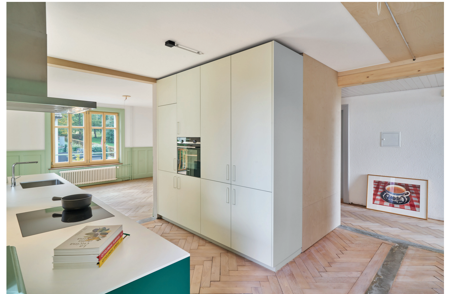
Die Eingriffe in die Bausubstanz wurden konzentriert eingesetzt: Die neue Küche ist Rücken an Rücken mit der neuen Toilette, welche über die bestehende, ehemalige Küchentüre erschlossen wird.
